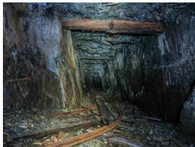
Slika: Opuščen podzemni tunel, iz katerega vodi železnica. Tiri so bili v veliko pomoč pri prevažanju izkopane rude - premoga. Vir: Canva
