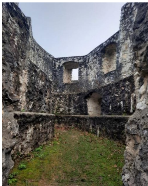
Slika 11: Notranjost obrambnega stolpa
