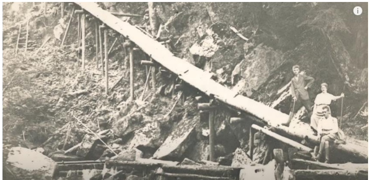
Slika 4: Vodne drče so služile za spravilo lesa. (Vir: Koroška. Kultura in dediščina)
