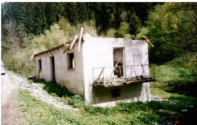
Slika 37: Ostanke stare delavske barake tik pred Suhim dolom pred rušenjem. Pred obnovo je bila tu prva žaga (Foto: Rudi Rebernik).
